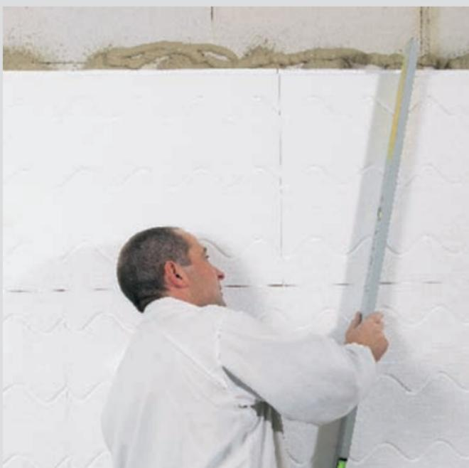
Выравнивание поверхности плит утепления
