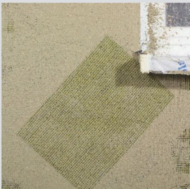
Армирование на углах оконного проема
