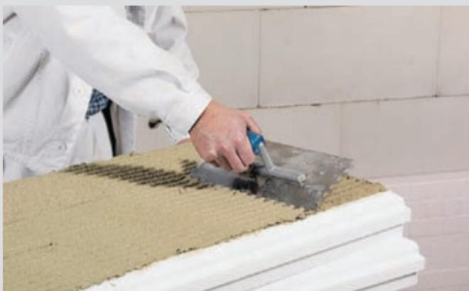
Нанесение штукатурно-клеевой смеси вручную, в случае ровного основания
